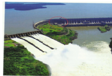
Figura 1: Barragem da usina de Itaipu e o trecho E em destaque.
